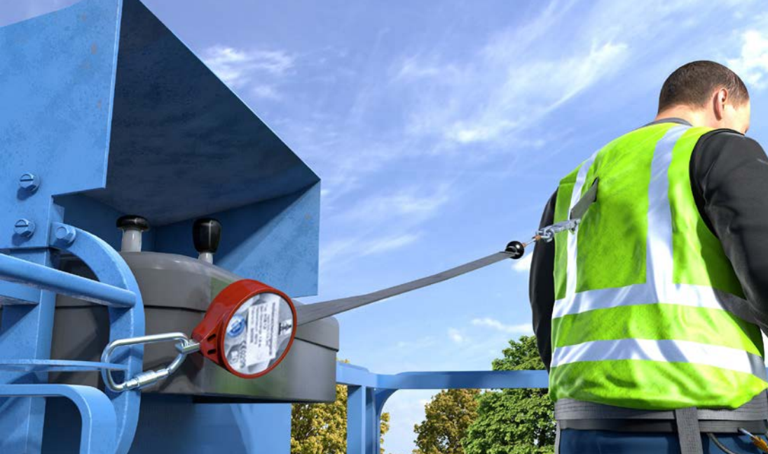
Abb. 43 Einsatz von PSA gegen Absturz in der Hubarbeits- bühne mit zugelassenem Anschlagpunkt
