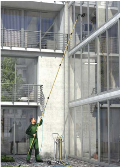
Abb. 63 Reinigen mit entmineralisiertem Wasser
