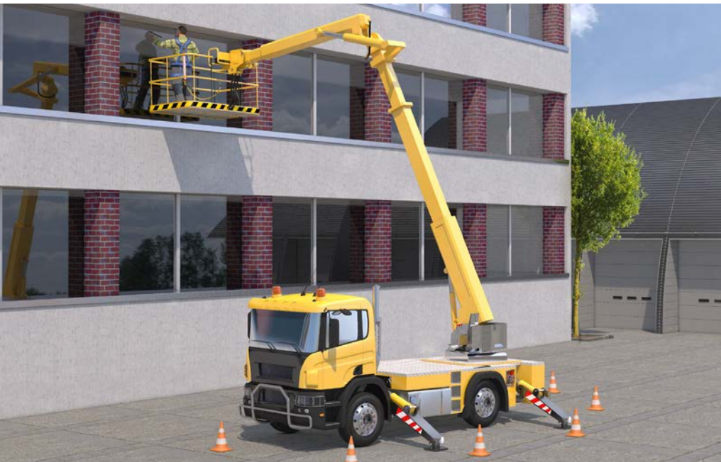
Abb. 41 Teleskopbühne im Einsatz
