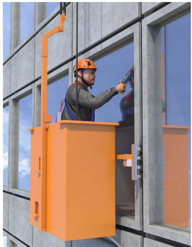
Abb. 62 Fassadenreinigung mit Fassadenbefahranlage
