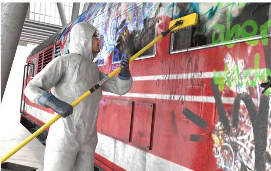
Abb. 78 Graffiti-Entfernung auf dem Betriebshof
