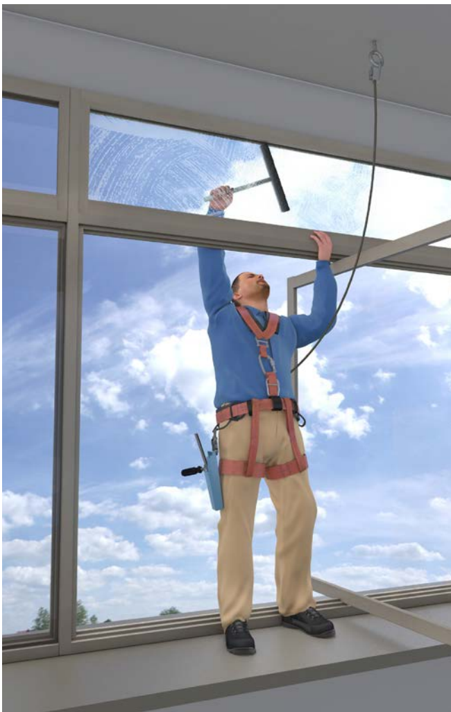
Abb. 1 Einsatz von PSAgA bei Fensterreinigung
